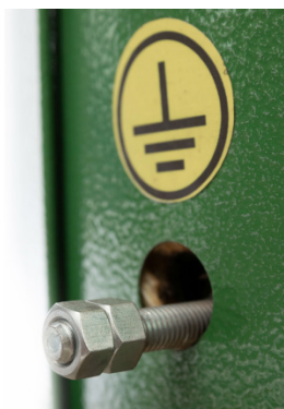
Рис. 4 Крепеж заземления
