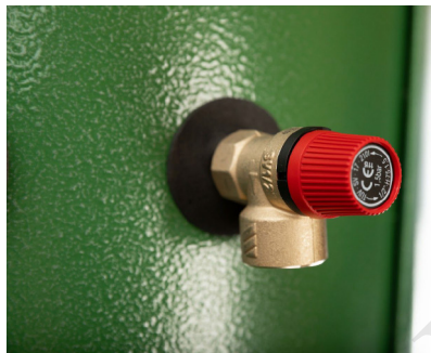
Рис. 14 Установка клапана безопасности
